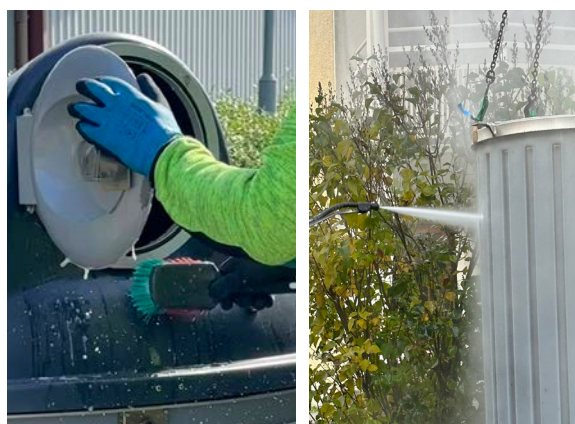
Rengöring av en helt nedgrävd underjordsbehållare
