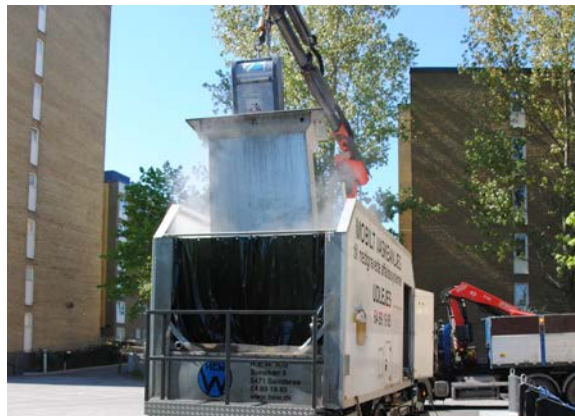
Rengöring av en helt nedgrävd underjordsbehållare
