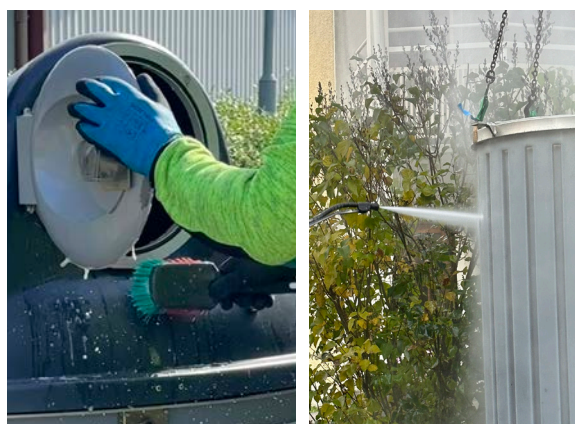
Rengöring av en helt nedgrävd underjordsbehållare
